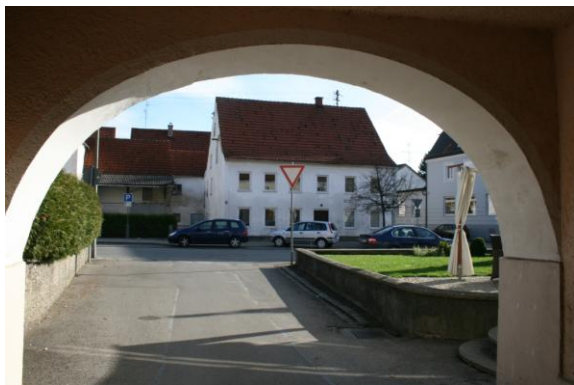
Bild 1: Das Koppenwallner'sche Anwesen, Schlossstraße 5 in Wolnzach vor dem Abbruch (Foto: Hans Biberger)
