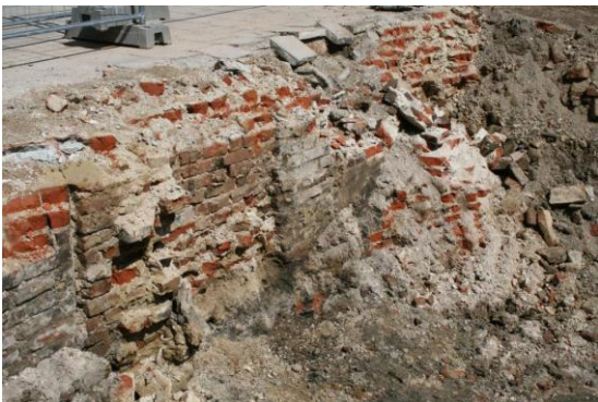
Bild 5: Außenmauer auf der Nordseite des „Padhauses“ von Wolnzach (Foto Hans Biberger)
