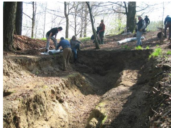
Bild 2: gesäuberte Grabungsgrube, Ausrollen des Flieses (Foto Hans Biberger)
